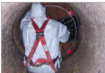
4.) Montagering auf Berme befestigen
