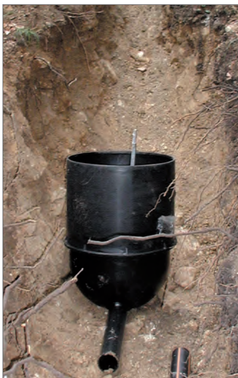
Rundboden mit Stutzen
