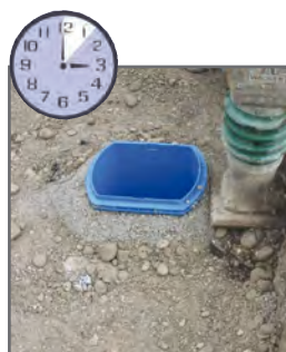
7. Minute: Verfüllen und verdichten
