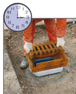
15. Minute: Aufsatz aufsetzen
