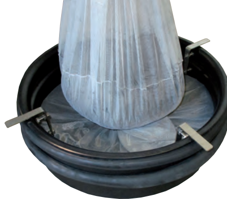
Zwei Säcke Aktiv-Kohle bei Verwendung für Druckleitungsschächte
