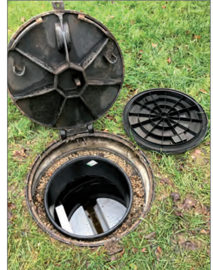
Beispielfoto Gerinneschacht im Überflutungsbereich
