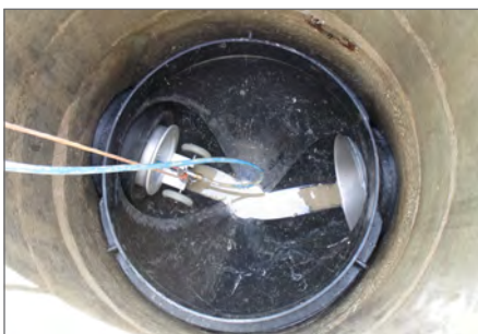
8.) Manschette (Quick Lock) an Ablauf und Zuläufen setzen, Verfüllen des Zwischenraums mit Verfüllmörtel
