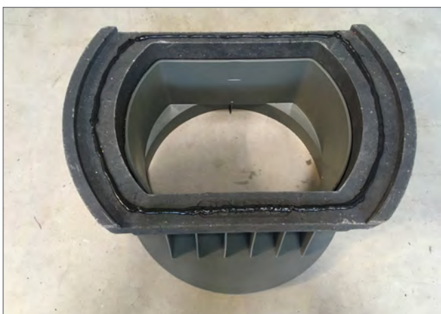
Kleber umlaufend auf PDRD 50.30/xx VS aufgetragen
