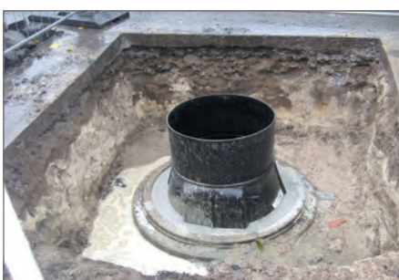
11.) Verfüllen des Zwischenraums zwischen PE-Schacht DN 800 und Betonschacht DN 1000 mit Verfüllmörtel
