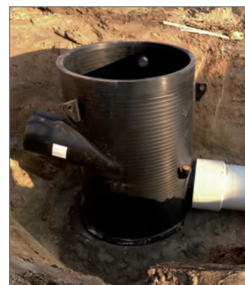
Beispiel Energieumwandlungsschacht DN 2000
