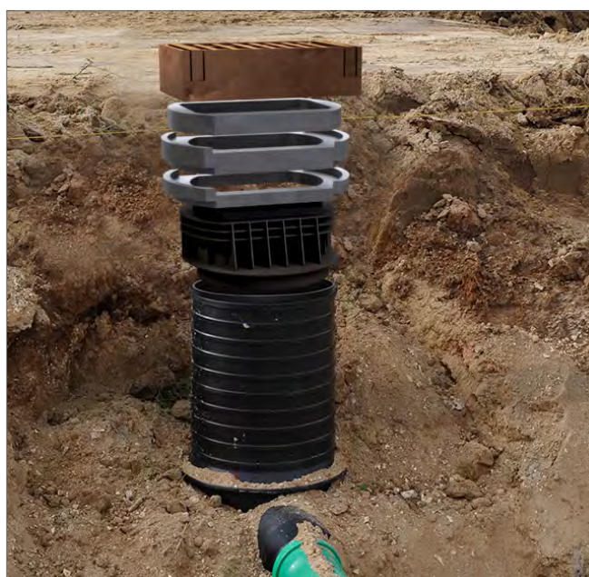
Nachträglicher Höhenausgleich mittels ROMOLD Kunststoff Ausgleichsringe PDRD
