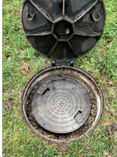
Deckel-in-Deckel-Lösung: Dichtfunktion durch PP-Deckel DN 625 Tragfunktion durch handelsübliche Abdeckung DN 800, Klasse D 400
