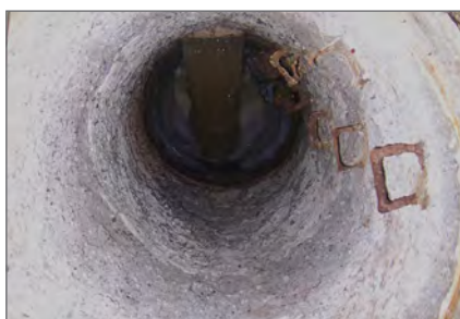
1.) Istzustand feststellen und Schachtdaten aufnehmen
