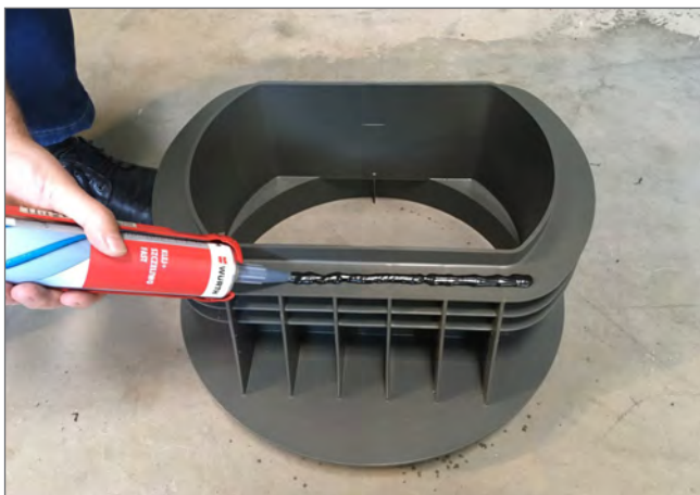
Kleber auftragen auf GRIT 40.50.30/13
