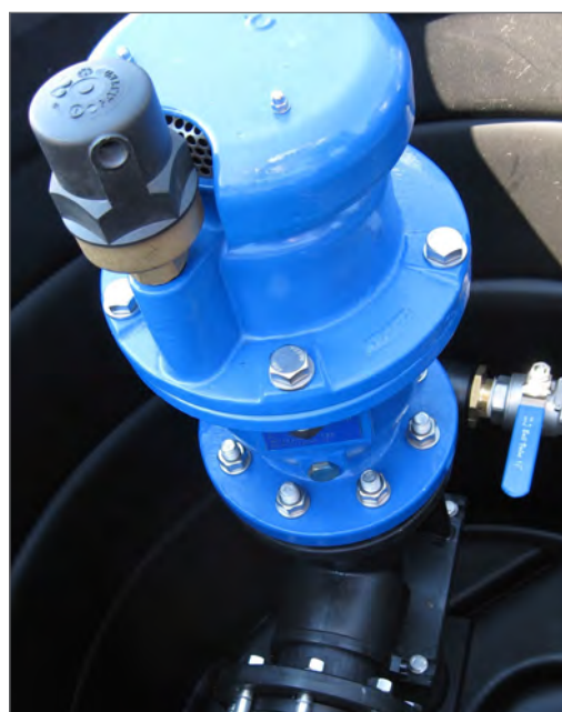
Be- und Entlüftungsventil mit Entleerungsmöglichkeit
