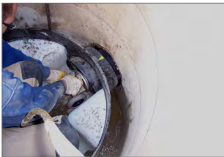
6.) Absperriblenden in Ablauf und Zuläufen setzen, Verfüllen des Zwischenraums mit modifiziertem Verfüllmörtel
