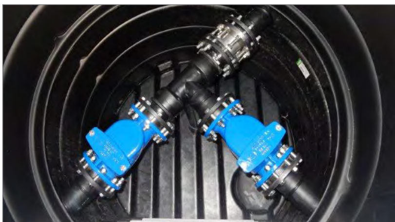
Abzweig mit Rückschlagklappen
