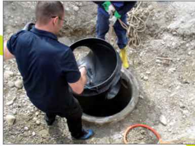
Neuen Boden in den Schacht ablassen
