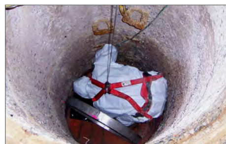
3.) Asphalt aufschneiden, Betonkonus abheben und Steigstufen entfernen
