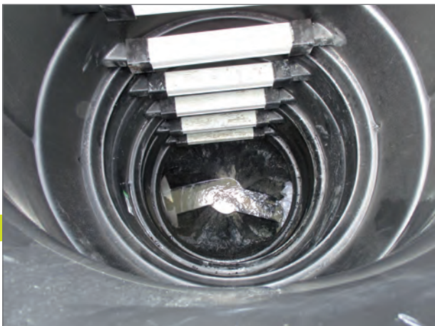
Neuer PE-Schacht DN 800 in korrodiertem Schacht DN 1000
