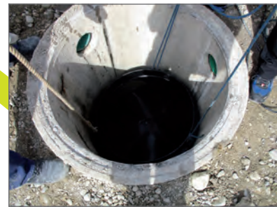
Neuen Boden in den Schacht ablassen
