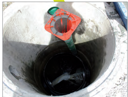
Zwischenraum verfüllen
