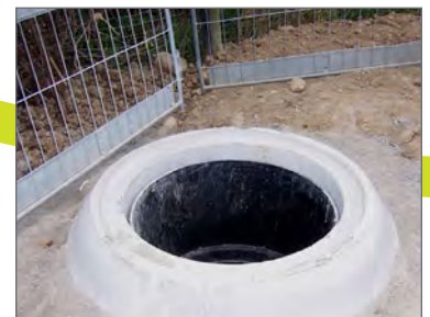
Lastentkoppelte Abdeckung.
