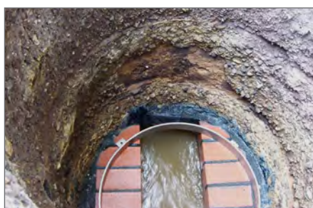
5.) Bild zeigt befestigten Montagering
