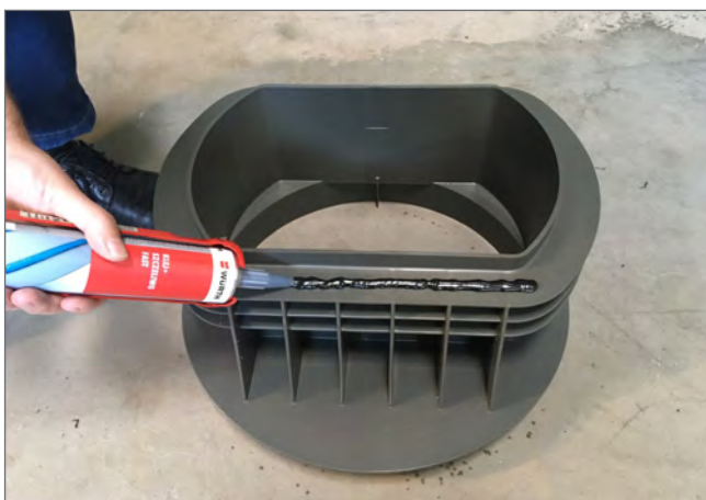
Kleber auftragen auf GRIT 40.50.30/13
