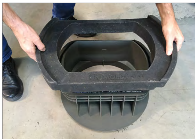
PDRD 50.30/xx VS in Kleber drücken
