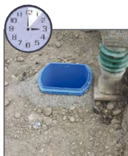
7. Minute: Verfüllen und verdichten
