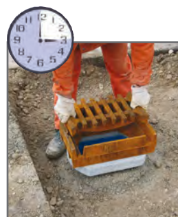
15. Minute: Aufsatz aufsetzen
