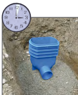
3. Minute: Schacht auf Magerbeton setzen
