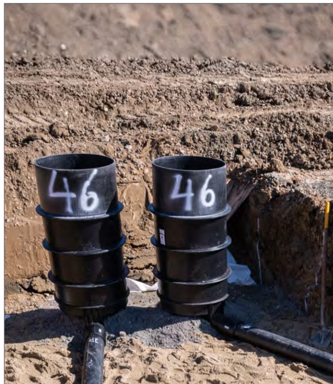
Hausanschluss monolithisch – geschweißte Rohrsysteme
