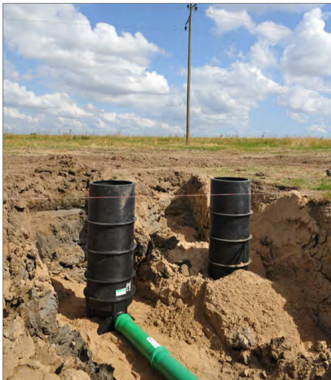
Hausanschlusschacht monolithisch – gesteckte Rohrsysteme
