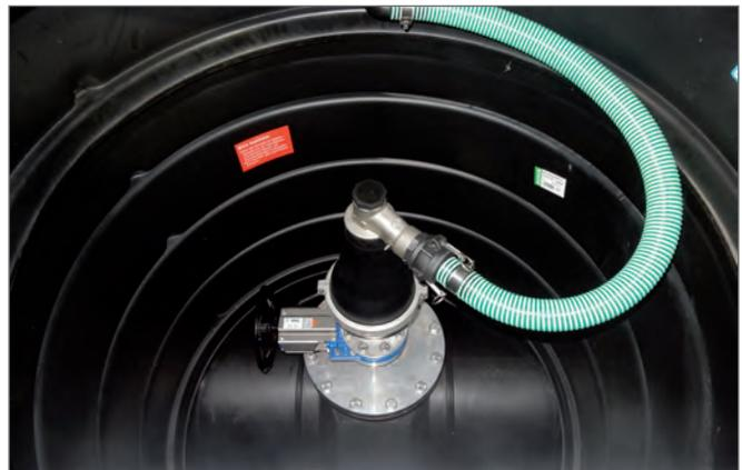
Hydrophobe Kunststoffschächte reduzieren das Korrodieren der Armaturen deutlich.
