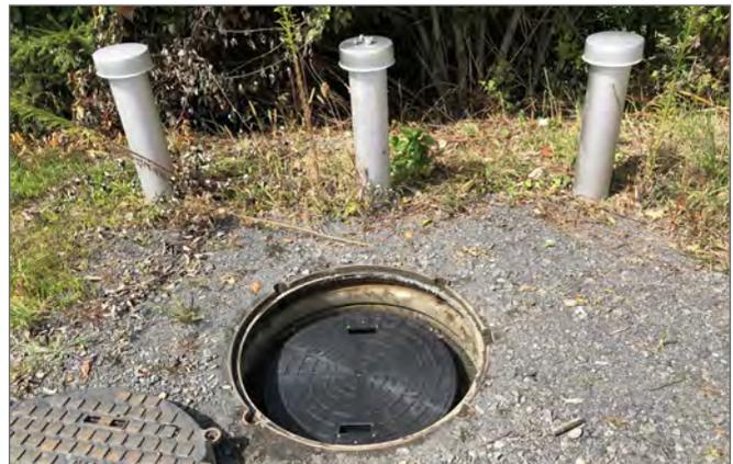
Die optimale Lösung, um Eindringen von Oberflächen- und Regenwasser in Armaturenschächte zu vermeiden: Das ROMOLD Deckel in Deckel System für echte Dichtigkeit.
