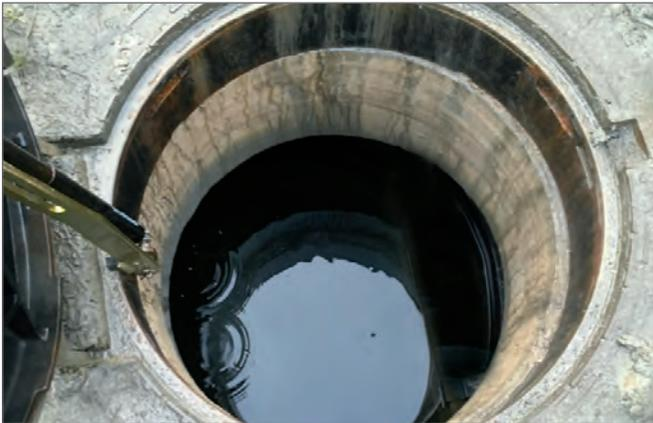
Grundwasser sorgt in vielen Fällen für die Flutung von Schachtbauwerken. Das anstehende Grundwasser sickert durch Risse oder fehlerhafte Dichtungen ins Schachtinnere.
