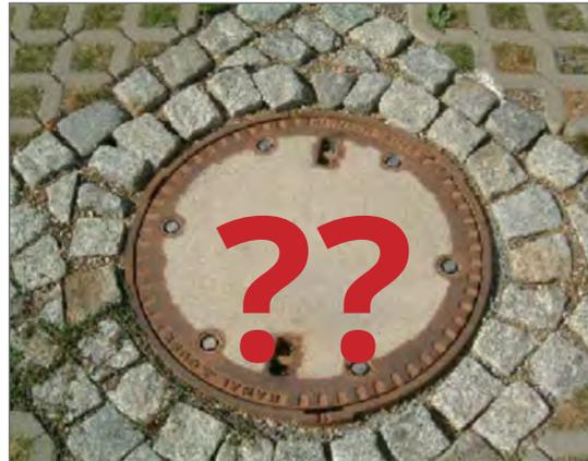
Oftmals hält eine tagwasserdichte Abdeckung nicht das, was sie verspricht. Wasser dringt am Rand der Abdeckung ein und sorgt für Wasser und Feuchtigkeit im Schacht.
