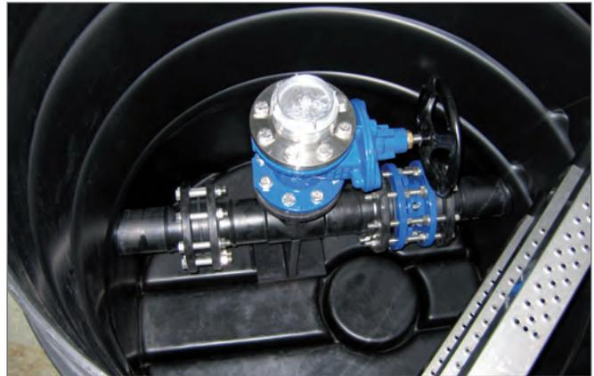
Die dreiseitige Elementdichtung (Tripple-Safety-Seal) oder eine von ROMOLD monolithische Bauweise sorgen für eine 100%ige Dichtheit des Schachtbauwerks.
