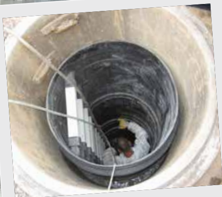
Lösung 2 Schacht-in-Schacht-Sanierung
