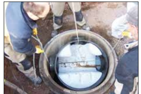
5.) Vorgefertigtes Gerinne mit PE-Stützen anpassen und in Schachtboden einbringen
