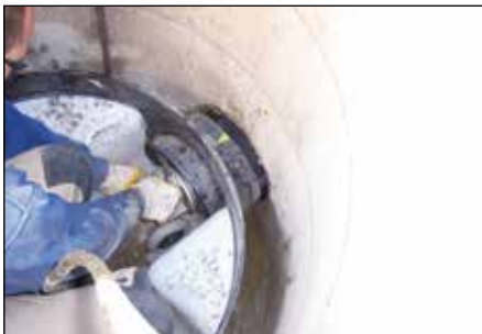
6.) Absperrblasen an Ablauf und Zuläufen setzen, Verfüllen des Zwischenraums mit modifiziertem Verfüllmörtel
