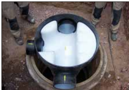
4.) Vorgefertigtes Gerinne mit PE-Stützen anpassen
