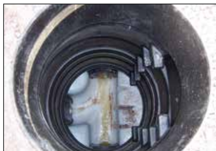
10.) Fertig sanierter Schacht. Steigstufen wurden auf Kundenwunsch nachträglich entfernt
