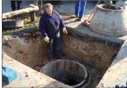
1.) Asphalt aufschneiden, Betonkonus abheben
