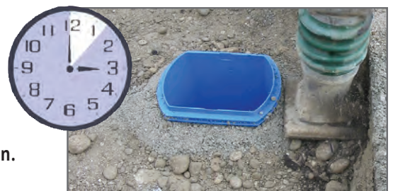
7. Min.: Verfüllen und Verdichten
