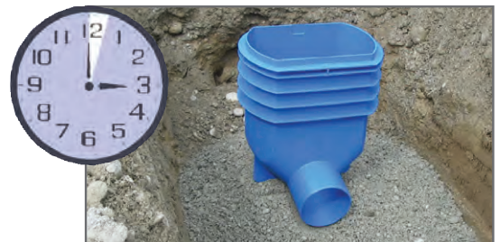
3. Min.: Schacht auf Magerbeton setzen
