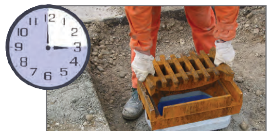
15. Min.: Aufsatz aufsetzen
